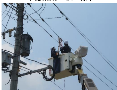
《間接活線工法の様子》
