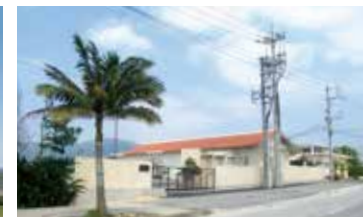
名蔵配電塔（石垣島） 「石垣市風景づくり条例」に基づき、赤瓦の屋根を採用し、景観に配慮した建屋外観としました。
