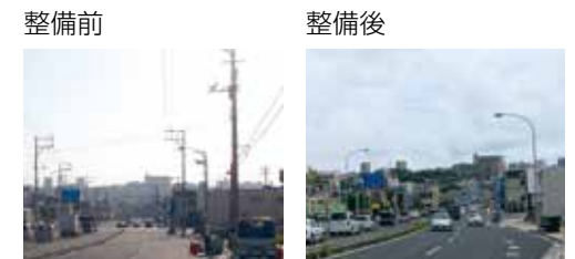
▲無電柱化の事例
