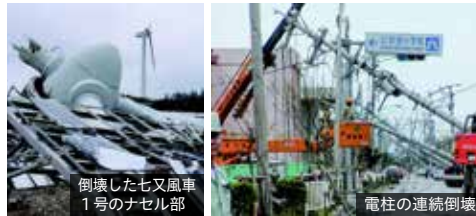
電柱の連続倒壊
