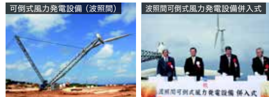
可倒式風力発電設備（波照間）
