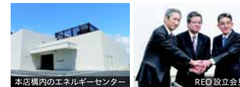
本店構内のエネルギーセンター
