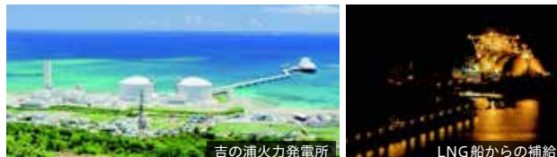
吉の浦火力発電所
