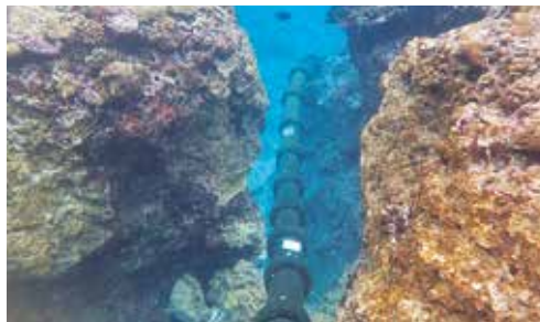
▲渡嘉敷島海底ケーブル敷設状況
