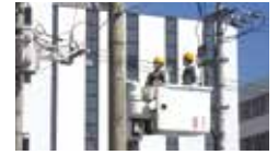
▲作業車を用いた配電作業の業務体験
