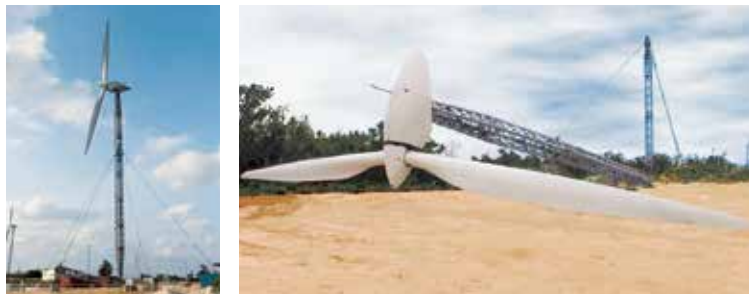
▲多良間可倒式風力発電設備・傾倒時
