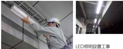
LED照明設置工事
