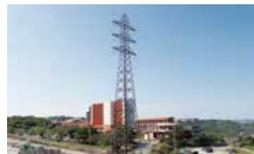
環境調和色送電線鉄塔（南城市） 「南城市景観まちづくり条例」に基づき、公共施設など一帯の景観および周辺環境に配慮した環境調和色送電線鉄塔（ダークブラウン）を採用しました。
