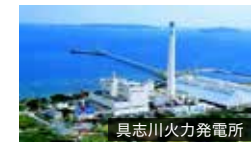
具志川火力発電所
