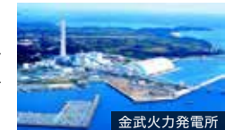
金武火力発電所
