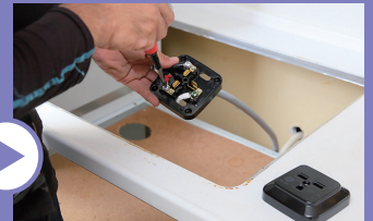
4 屋内へIHクッキングヒーター専用のコンセントを取り付けます。
