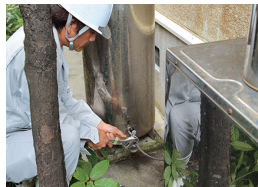
2 接続されている配管を切り離していきます。
