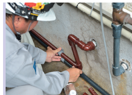
8 エコキュートに既存の給水・給湯配管を接続します。※6
