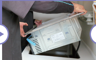
6 IHクッキングヒーターをシステムキッチンへはめ込みます。
