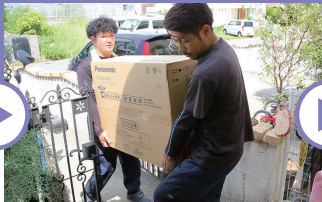
5 IHクッキングヒーターを設置場所まで運びます。
