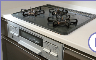
1 取外し前のガスコンロです。
