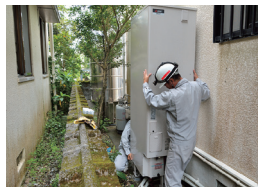
7 エコキュートを設置します。
