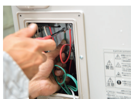
11 エコキュート専用(200V)配線とリモコンの配線を接続します。
