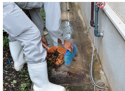
4 今回は基礎工事が不要なので、設置場所をきれいに掃除します。※4
