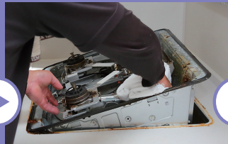
2 システムキッチンからガスコンロを取外します。※1
