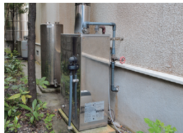
1 取外し前の石油ボイラーと石油タンクです。
