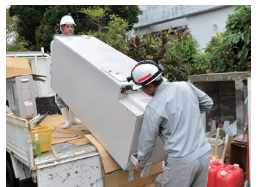
6 エコキュートを設置場所まで運びます。
