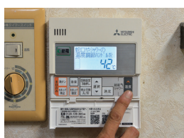
13 試運転をし、完了です。
