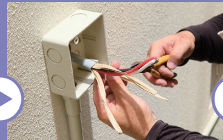
3 IHクッキングヒーター専用(200V)配線を準備します。※2
