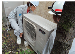
9 ヒートポンプユニットを設置します。
