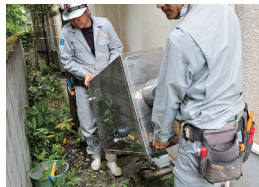
3 切り離れた石油ボイラーと石油タンクを撤去します。※3
