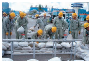
▲土のう積み(牧港火力発電所)
