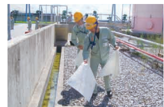
▲吸着マット敷き(金武火力発電所)
