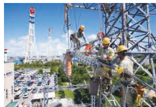
▲電線張替の復旧訓練
