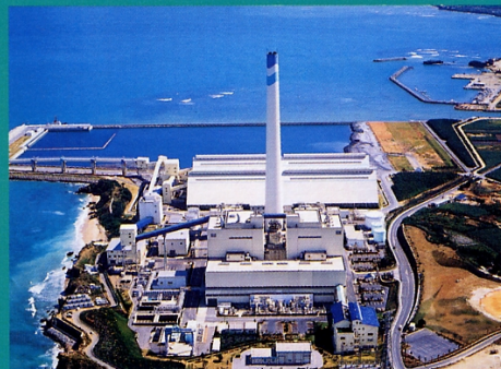
具志川火力発電所
