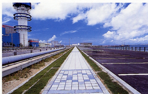
せきたんばい 石炭灰を利用したタイル(牧港火力発電所内の歩道)
