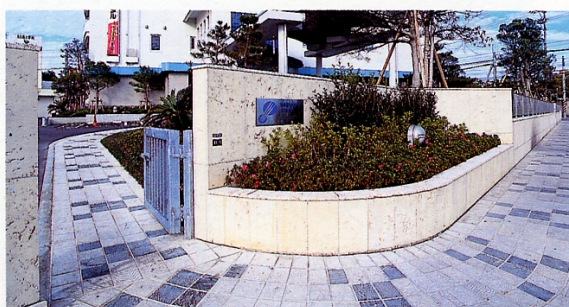
せきたんばい 石炭灰を利用した人造石及びタイル(おきでん牧港ビルのへいや歩道)
