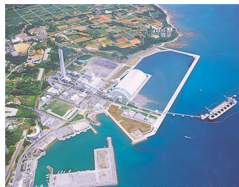
金武火力発電所
