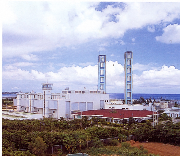
石垣第二発電所
