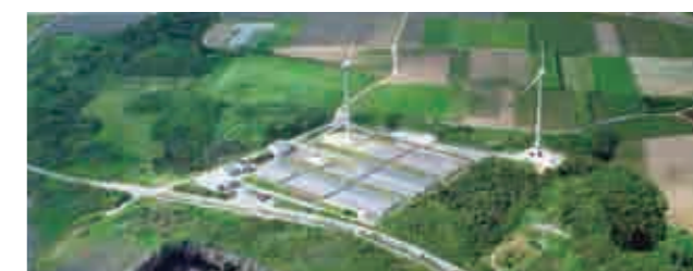
▲宮古太陽光発電実証研究設備(後方は、沖縄新エネルギー(株)の風力発電設備) 2003年の台風14号で太陽電池パネルの約3割が被害を受けましたが、残りの健全部分の太陽電池パネルを使用し、2006年3月に運転を再開しました。
