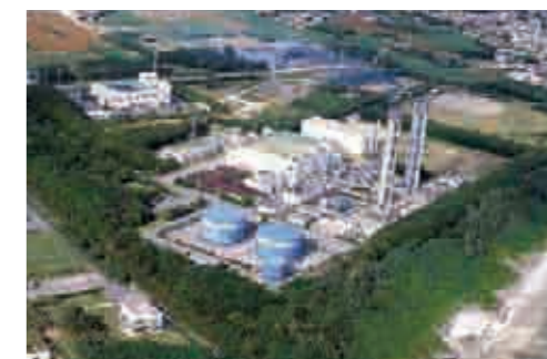
▲緑の発電所(石垣第二発電所)
