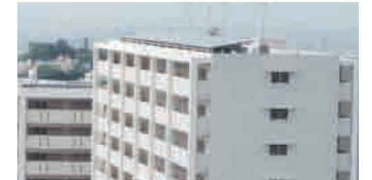
▲石嶺市営団地に太陽光発電設備を設置
