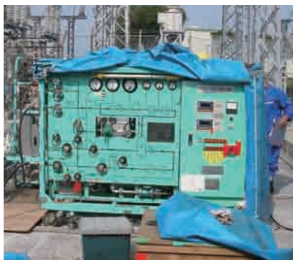
▲SF 6 ガス回収作業
