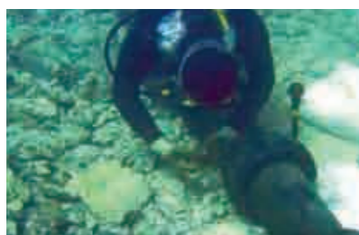
▲環境に配慮した海底ケーブル設置 (今帰仁～伊是名間) サンゴが生息する海域ではサンゴ間の溝にケーブルを敷設することのできる工法や国内初の弧状水平ポーリング工法を用いるなど、環境に配慮した海底ケーブルの設置を行っています。
