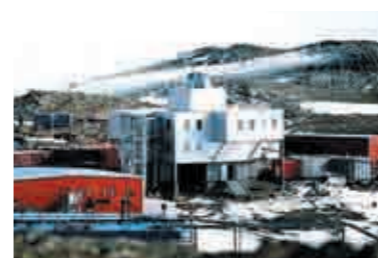
▲昭和基地管理棟
