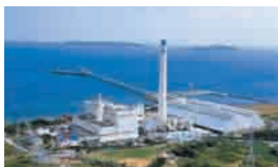
▲具志川火力発電所 具志川火力発電所はGマーク P72 (施設部門)の認定を1996年10月に受けました。発電所の緑化が高く評価されています。
