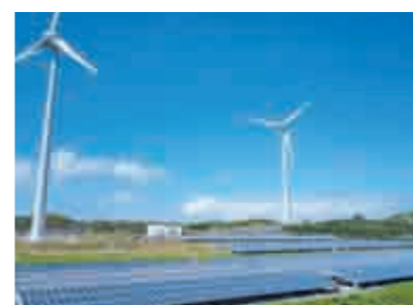
▲宮古島サデフネ風力発電所(900kW×2基)
