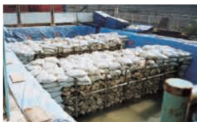
▲赤土等流出防止対策 (浦添変電所新設工事) 沖縄県では、降雨、土壌の性質、地形などから赤土などが流出しやすくなっています。赤土等流出防止対策のため土のうや浸水ネットなどで赤土流出防止柵を設置するなど、沖縄県赤土等流出防止条例に基づいた工事を実施しています。
