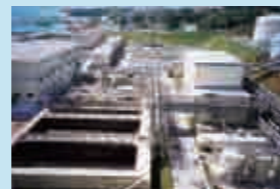
▲総合排水処理装置
