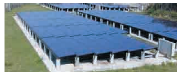
▲北大東太陽光発電実証研究設備 アモルファス太陽電池は、夏場の温度上昇に強く沖縄の気候に最も適した太陽電池であることが実証されています。本格的普及に向け研究を行っています。
