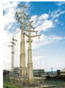
沖縄の幹線道路として交通量の多い宜野湾市伊佐交差点に設置した鉄塔には、沿道建物との調和に配慮した部材や形状・塗料などを考慮した環境調和型送電線鉄塔を採用しました。
